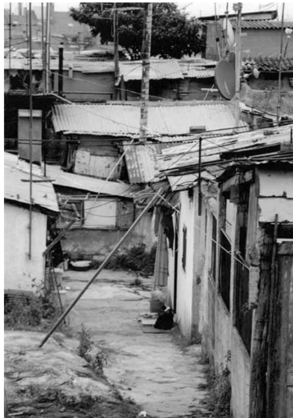
FIGURA 6: SITIO ANTES DE LA DEMOLICIÓN.
